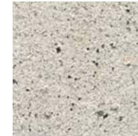
superficie tratada con chorro de arena de granito
